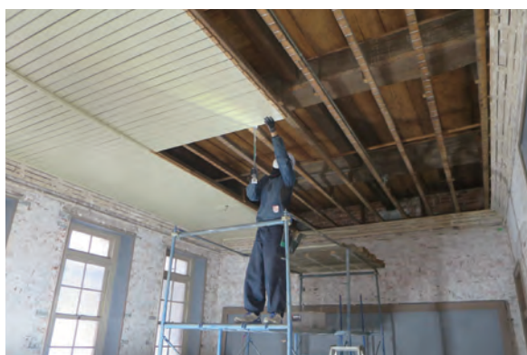
【写真4】本館：天井板解体
