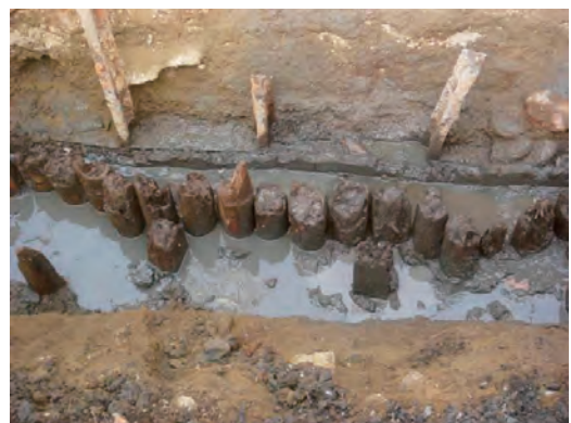
【写真16】三菱一号館 摩擦杭と板杭
