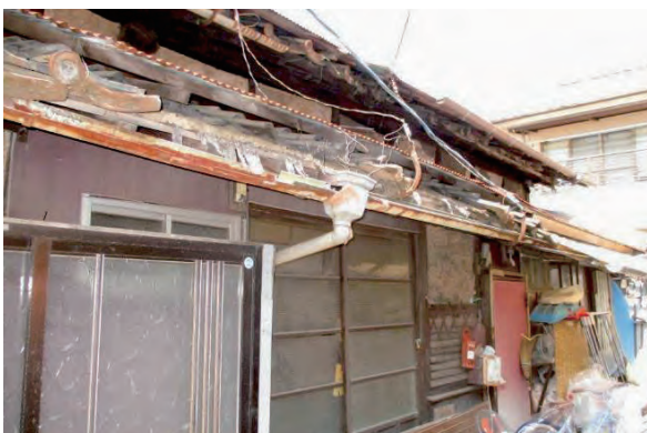
【写真1】建物外観
