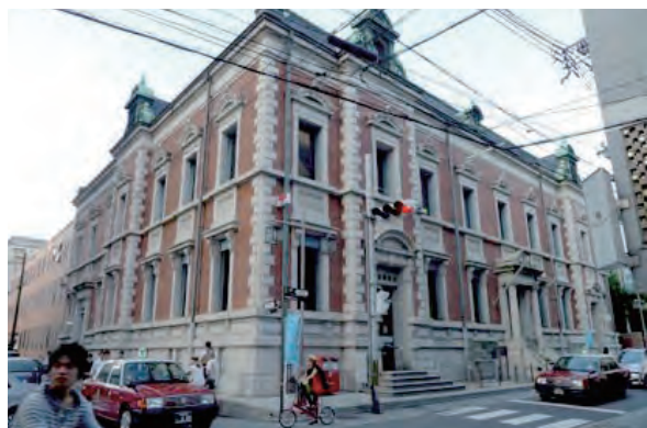
【図4】外壁保存を行った中京郵便局(内田撮影)
