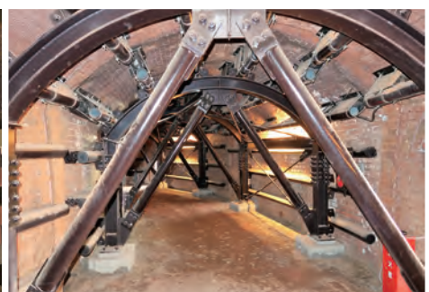
【写真11】煉瓦窯内部(見える補強)
