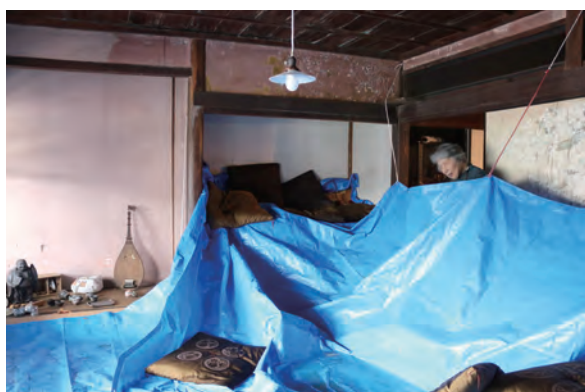
【写真4】地震の被災状況 屋根が落ち雨漏りする座敷にブルーシートを掛ける富士田さん(塩屋)
