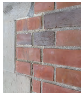
【写真2】化学実験場： 煉瓦工事煉瓦補修完了
