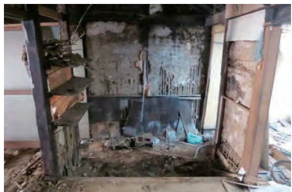
【写真2】土間空間
