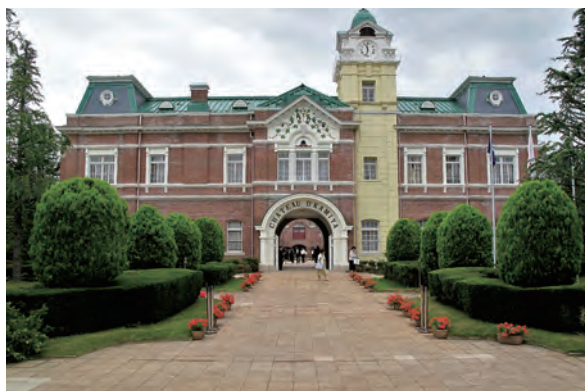
【写真2】シャトーカミヤ旧醸造場 事務室(本館)
