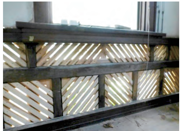
洋間腰壁 木摺補強 撮影坂田
