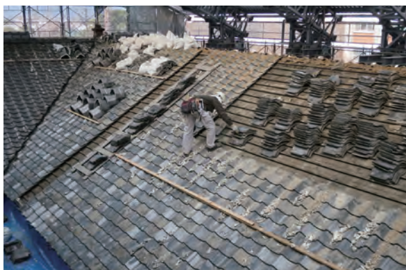
【写真1】本館：屋根瓦解体(凡そ19,000枚程)
