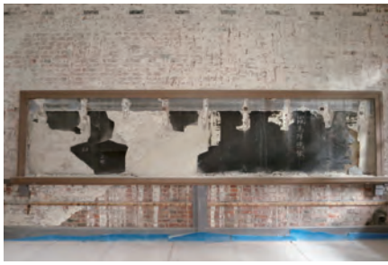
【写真6】本館：復原教室の黒板に残る 漆喰黒板跡
