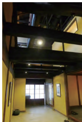
【図13】内部の小屋組(内田撮影)
