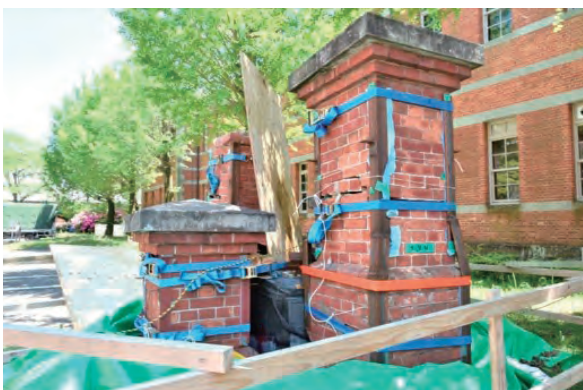
煙突の仮撤去
