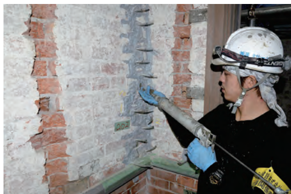
【写真12】本館：シリンダーガンを使用しての注入
