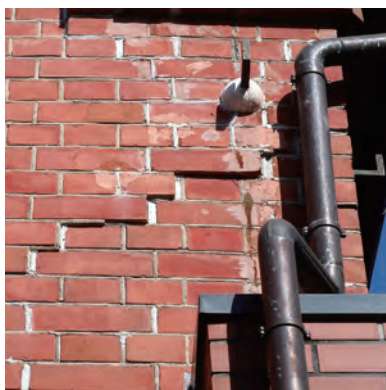
【写真6】煉瓦蔵外壁
