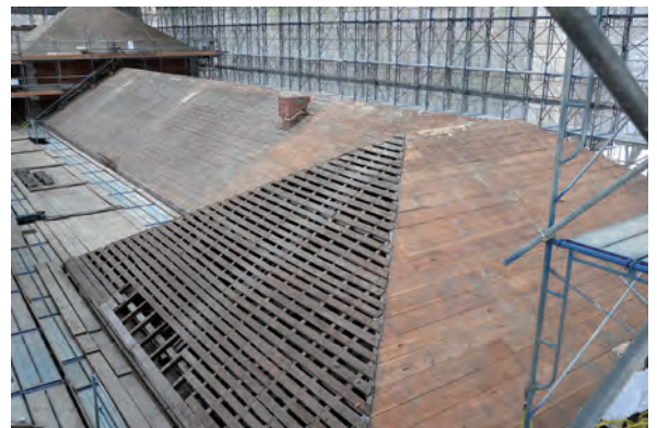
【写真9】化学実験場：野地板解体
