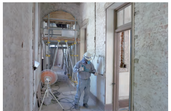
【写真10】化学実験場：漆喰塗り解体
