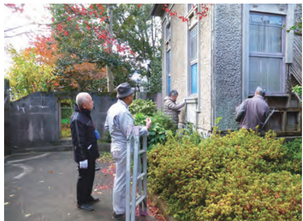
洋間外壁状況調査 撮影井田
