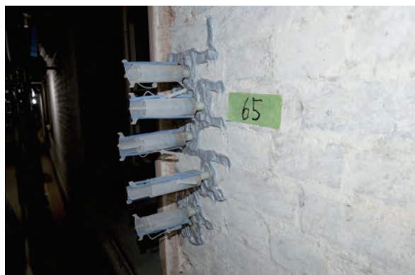
【写真11】本館：ひび割れ補修低圧式ノズルを使用
