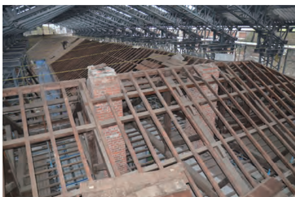
【写真2】本館：屋根野地板解体(煉瓦積み煙突の状況)
