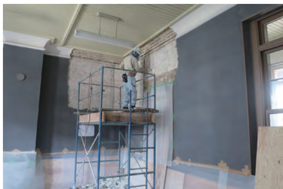
【写真3】本館：漆喰塗り解体
