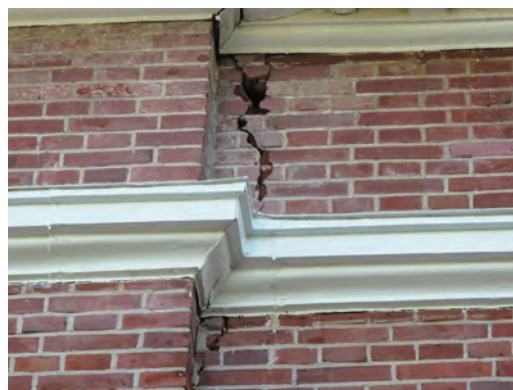
【写真4】事務室(本館)の外壁
