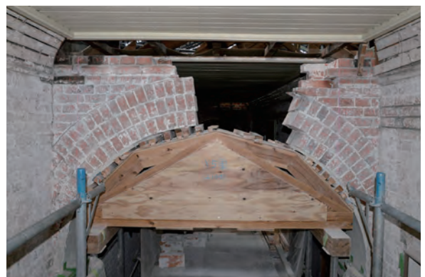
【写真10】本館2階廊下：アーチ梁煉瓦積解体
