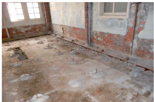
【写真12】旧機械実験工場：床板解体(煉瓦敷残存)
