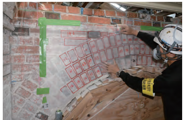
【写真9】本館2階廊下：アーチ梁原寸写し取り
