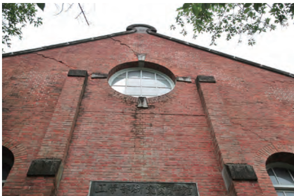
【写真7】旧機械実験工場：東妻壁見上げ
