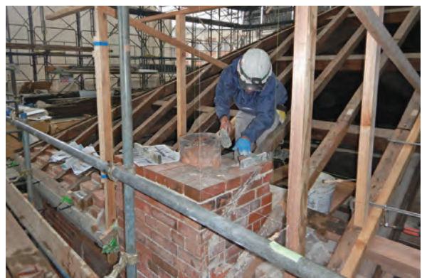
【写真5】 化学実験場：煉瓦積煙突No.7の煉瓦積み直し
