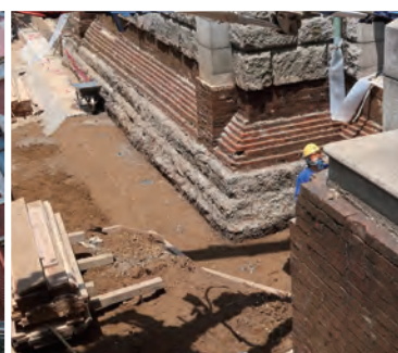
【写真14】免振工事
