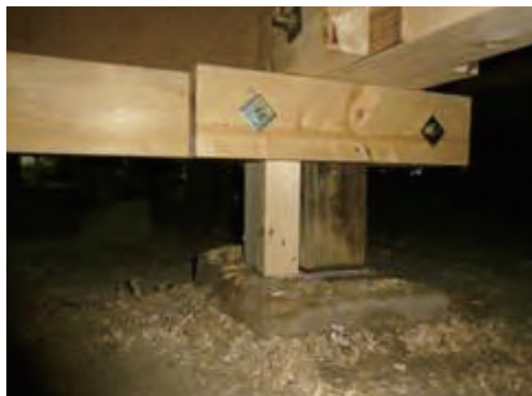
床下根固め補強 撮影坂田
