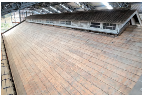
【写真11】旧機械実験工場：野地板解体
