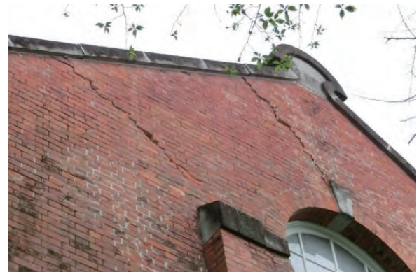
工学部研究資料館 外壁
