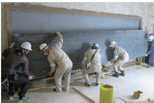
【写真5】本館：各教室の黒板解体(下に鼠漆喰が残る)
