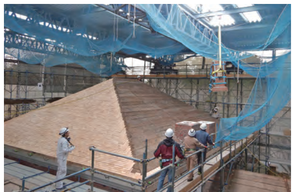
【写真6】 化学実験場：煉瓦積煙突の吊り込み作業
