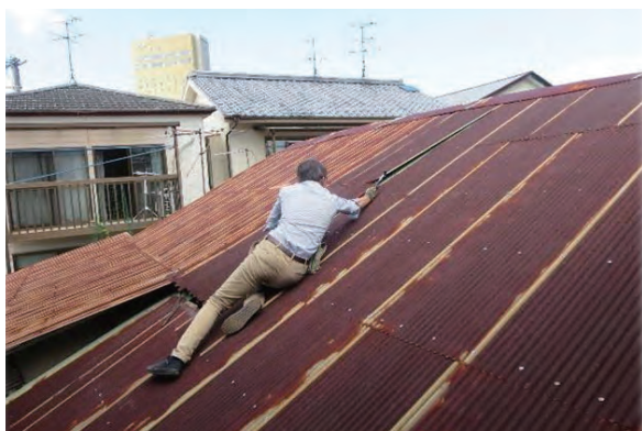
【写真5】屋根の修理中
