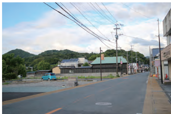
【写真3】地震後、公費解体により空き地が増えた小川町商店街
