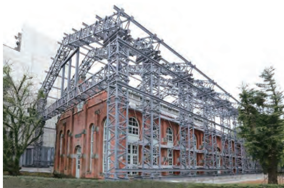
工学部研究資料館 仮設補強
