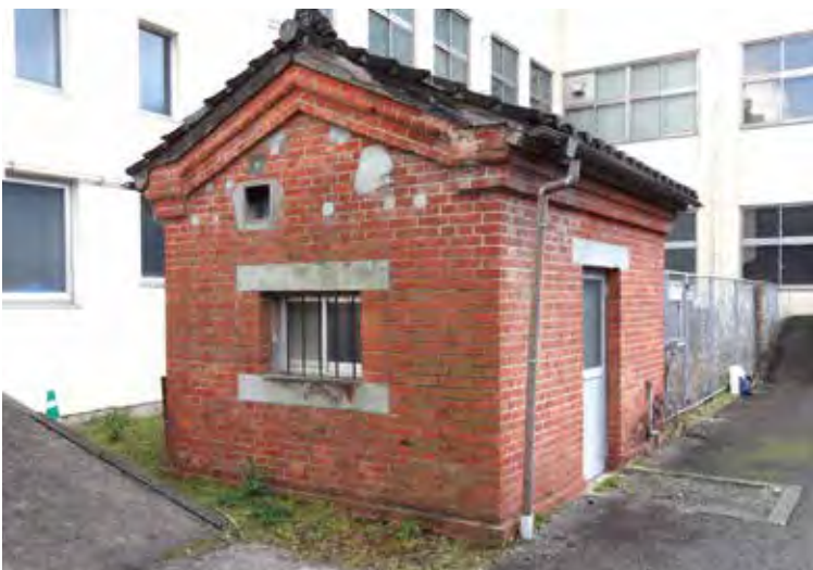
【図1】黒髪北地区にあるれんが造倉庫
