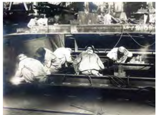
43 三菱重工業長崎造船所での鉋打ち作業
