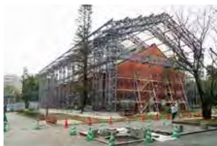
鉄骨のフレームが組まれ安全性が確保された
