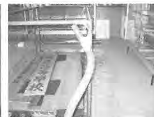
投薬ホース設置
